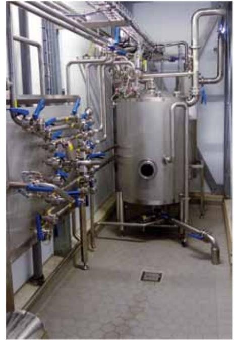
**Fig. 3** Sistema de trampa de espuma de nuevo diseño para hasta ocho tanques y panel de distribución CIP semiautomático con codos pivotantes
