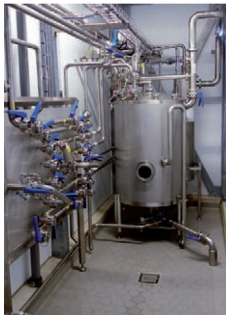
**Илл. 3** Новая разработка – система пеноулавливания, которая может обслуживать до восьми танков, и распределительная панель полуавтоматической безразборной мойки с поворотными патрубками
