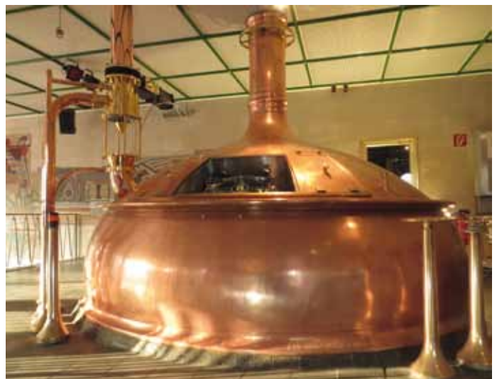
Von der einzelnen Anlagenkomponente bis zum kompletten Sudhaus: die Prozesstechnikspezialisten sind in zahlreichen Brauereien vertreten, hier bei der Brauerei Höpfner
