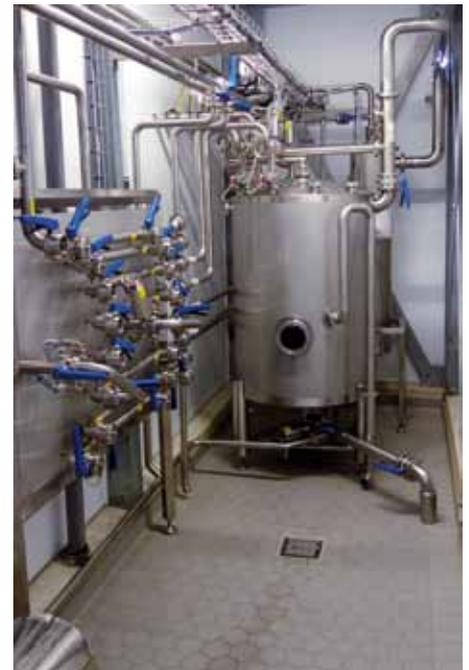
**Abb. 3** Neu entwickeltes Schaumfängersystem für bis zu acht Tanks und halbautomatisches CIP-Verteilerpaneel mit Schwenkbögen
