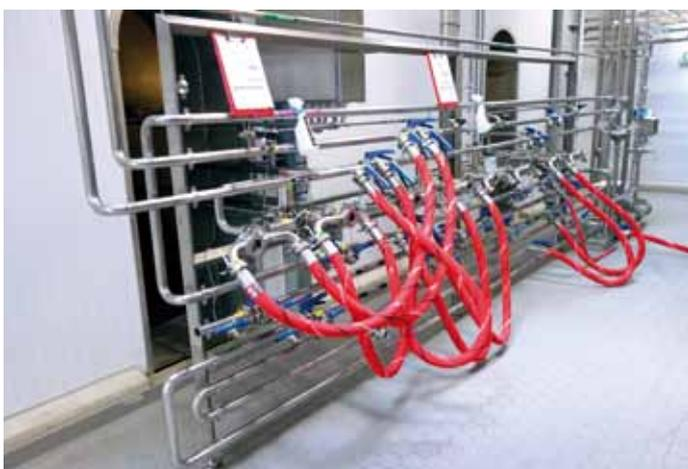
**Abb. 4** Rohrzaunpaneel mit Schwenkbögen und flexiblen Schlauchverbindungen
